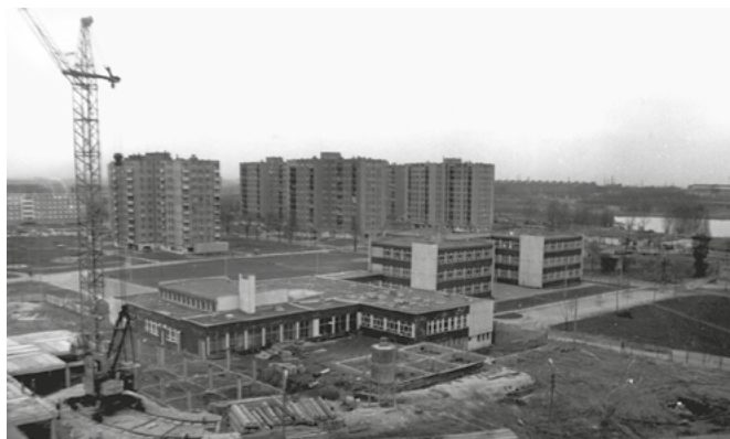
Budowa Przedszkola nr 55
